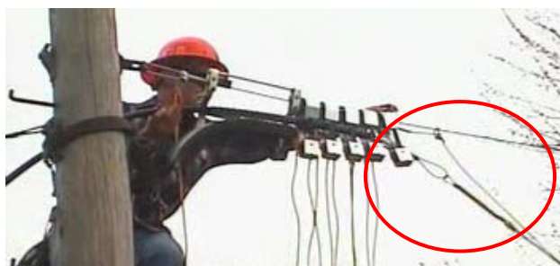
图6.1-2 牵引绳安装示意图
