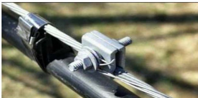
图6.2-1 双绞缠绕钢丝终端示意图
